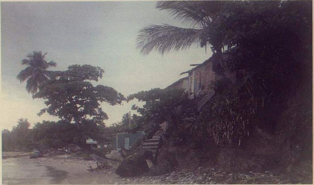
*Imagen V.30. Escarpes de erosión en la zona del Perfil 3. Se observa la proximidad de las construcciones al borde del escarpe.*
