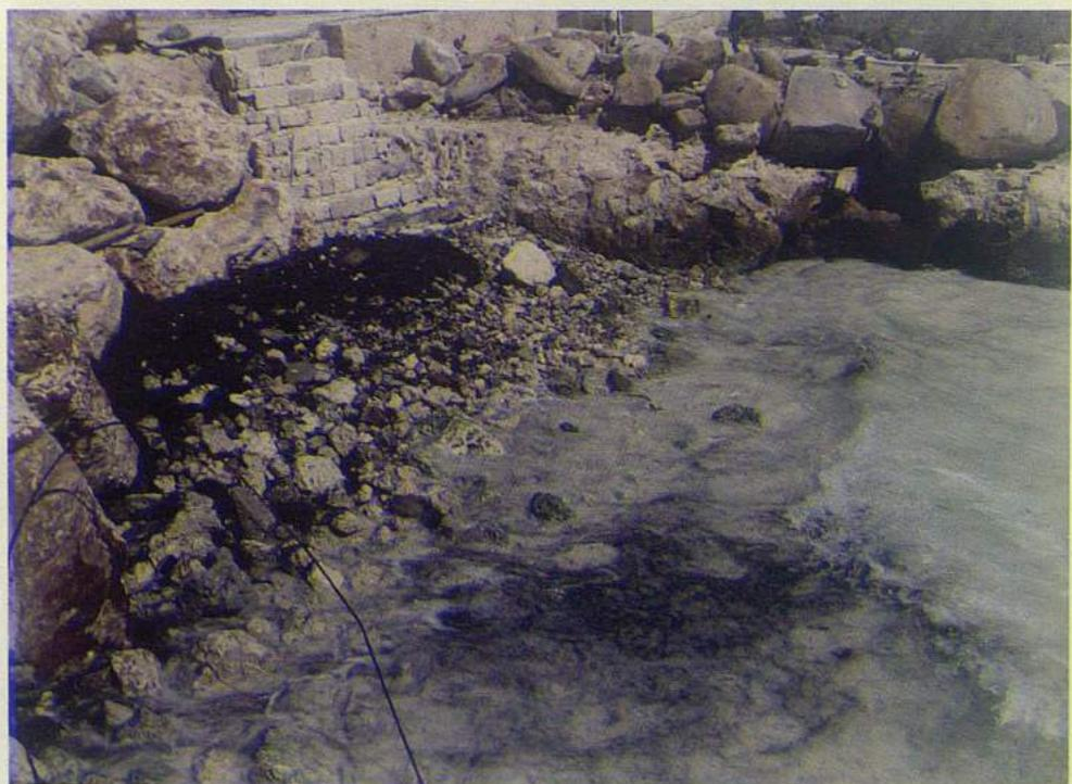
*Imagen IV.32. Destrucción de la instalación producto de la pérdida de sedimentos por la erosión.*
