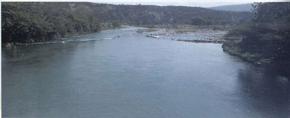
● Río Yaque del Sur aguas abajo del muro de la presa de Sabana Llegua
