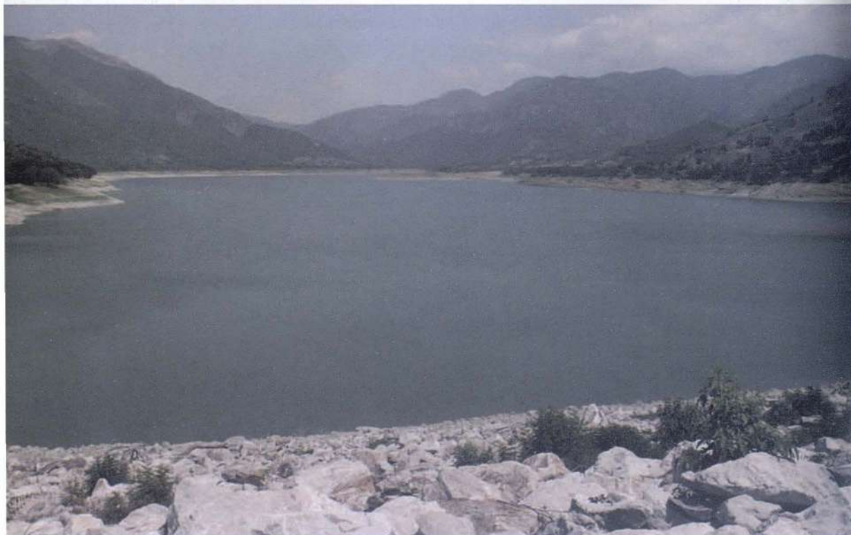
● Presa de Sabaneta sobre el río San Juan, Cordillera Central.
