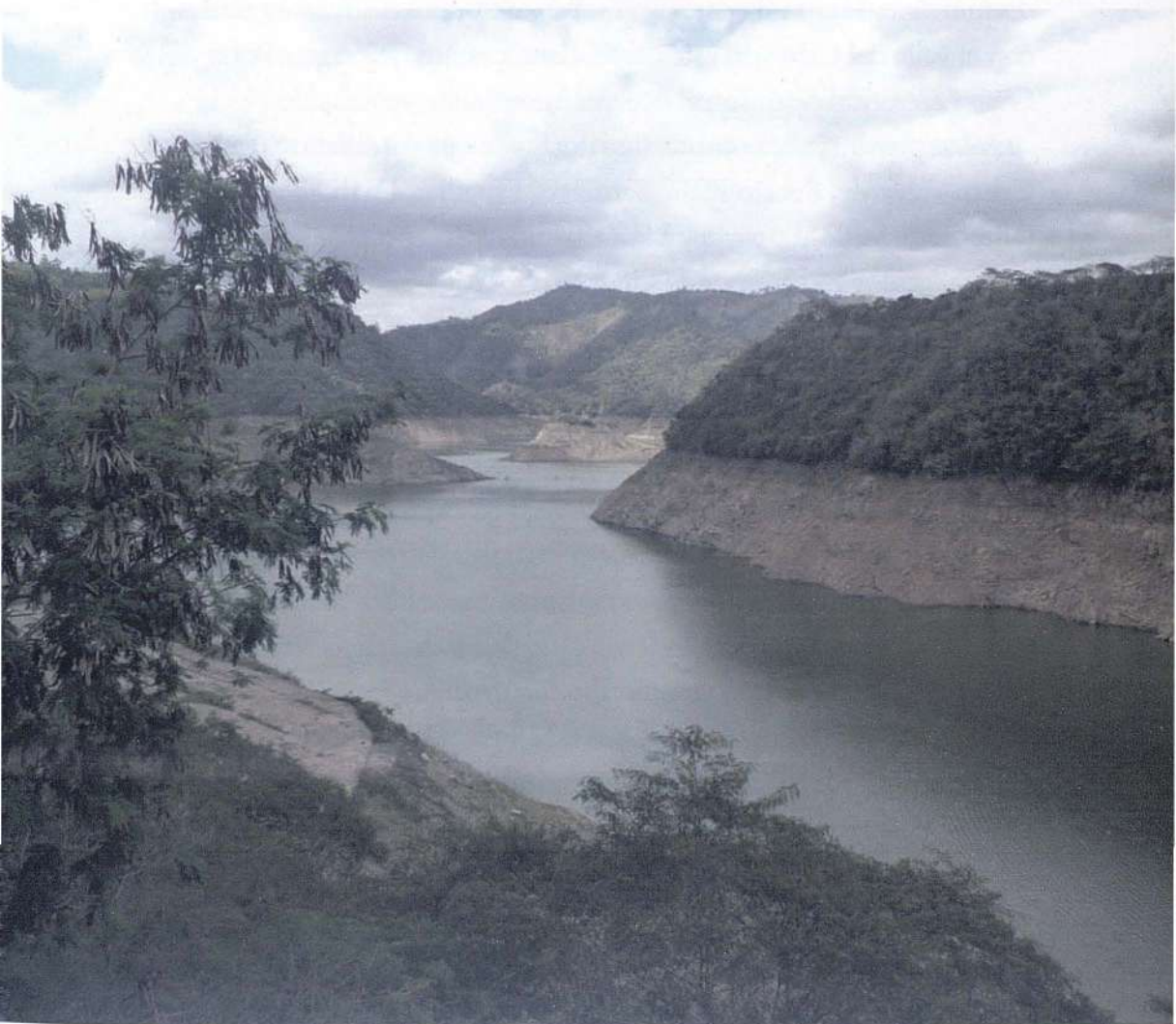
● Lago de la presa de Jigüey, cordillera Central.
