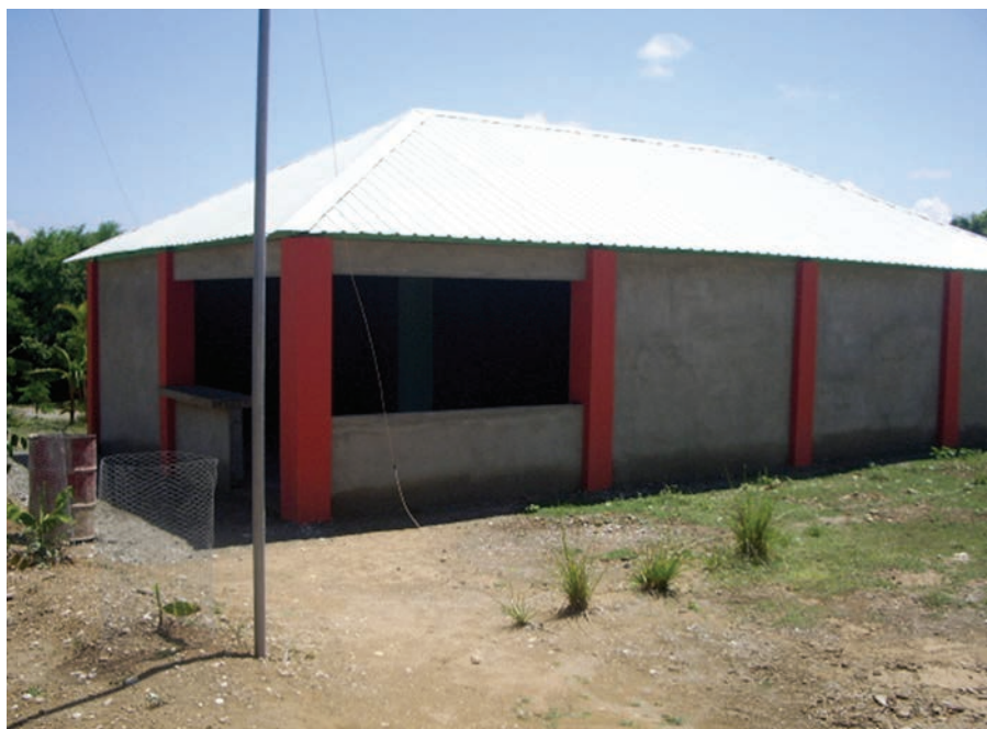
Construcción de almacén
