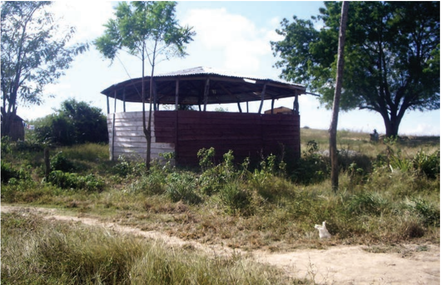
Construcción de gallera
