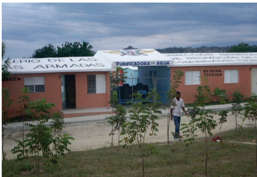
Planta de tratamiento para agua potable
