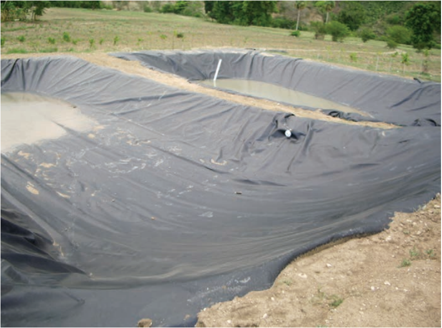
Construcción de estanques para peces, camarones y ranas
