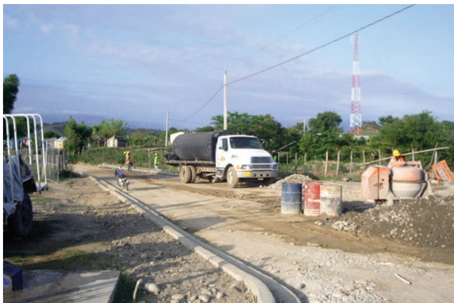
Construcción de aceras y contenes
