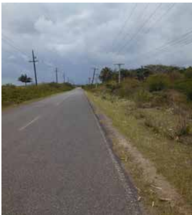
Carretera que va a Hato Viejo, al norte de la vieja carretera Mella.
