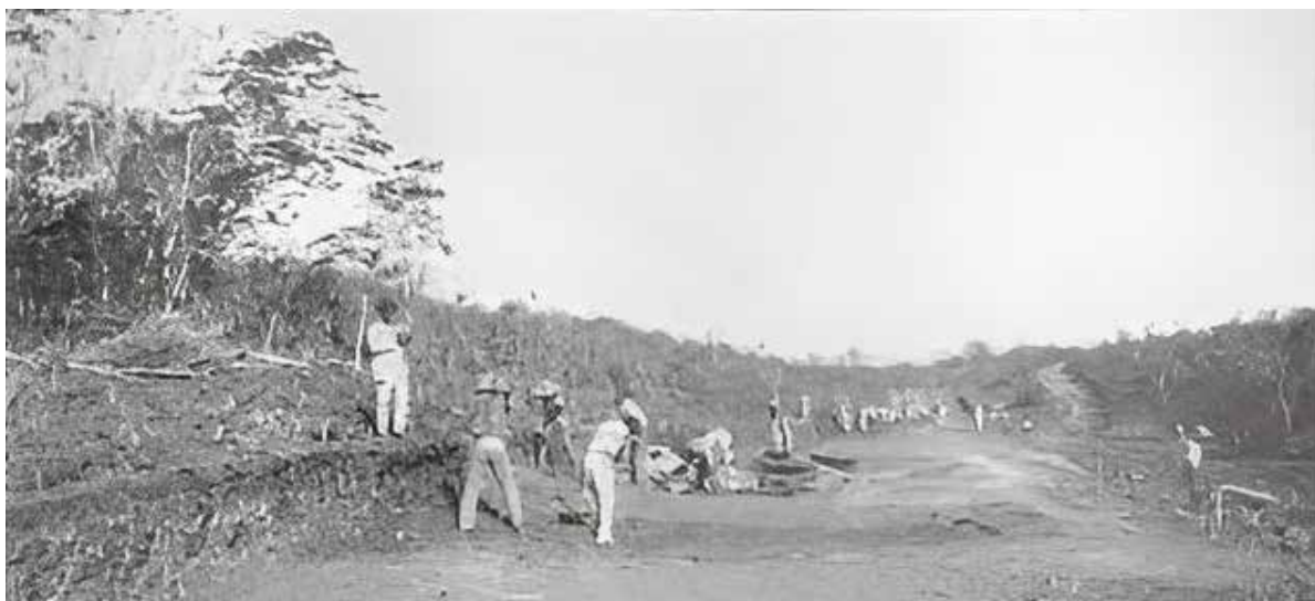
Obreros trabajando en la construcción de un tramo de la carretera Duarte (Fuente: Pinterest . En línea).
