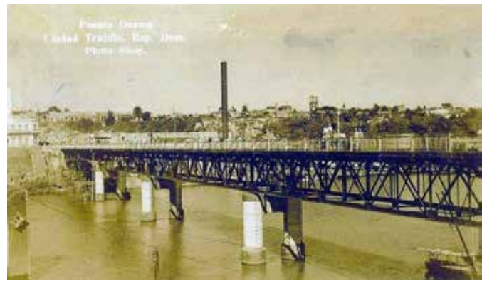
Puente sobre el río Ozama, reconstruido en 1917 con hormigón armado (recuperado de: Historia Dominicana en Gráficas . 20 de junio de 2015. En línea).
