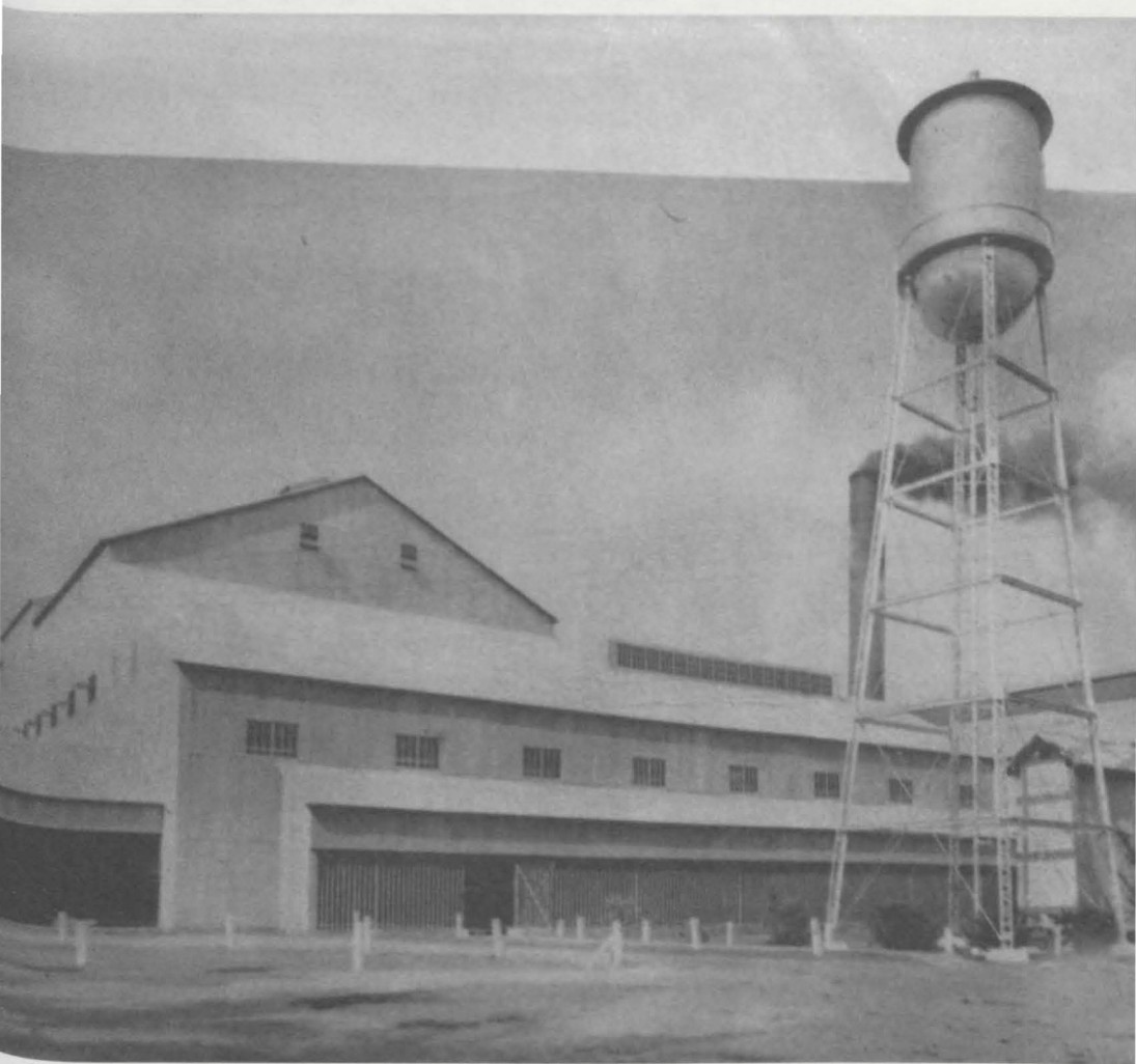
Casa de máquinas del ingenio Santa Fe a inicios del siglo XX. San Pedro de Macorís, República Dominicana.
