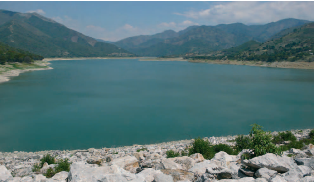
● Presa de Sabaneta sobre el río San Juan, Cordillera Central.
