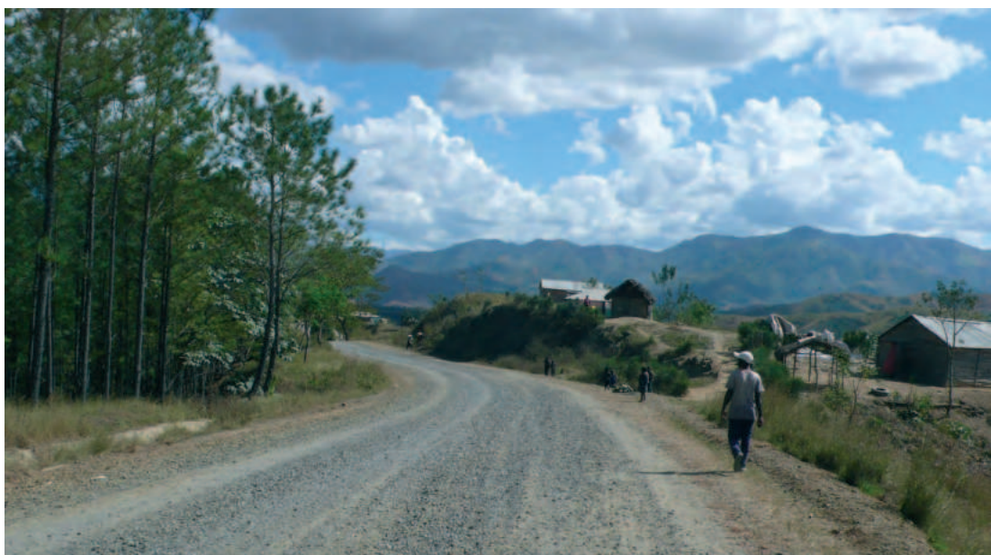
● Carretera internacional, tramo Villa Anacaona-Pedro Santana
