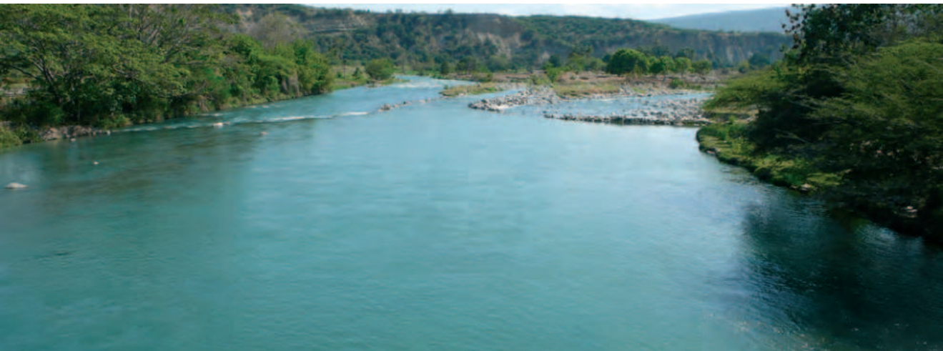
● Río Yaque del Sur aguas abajo del muro de la presa de Sabana Llegua
