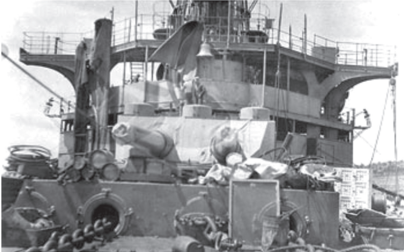
El Memphis durante la fase de desmantelamiento inicial. Desde el extremo de proa se observan el güinche de las cadenas de anclas, la torre artillera con sus dos cañones protegidos y la estructura del puente con la torre de mando de batalla (coning) en su centro. La campana cuelga del frontispicio del puente. (Foto #NH 82102).
