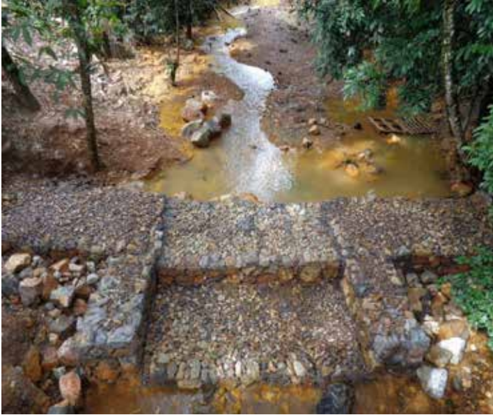
Figura 17. Diques de sedimentación
