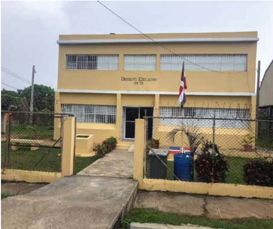
Figura 1. Edificio administrativo del Distrito Educativo 05-05, municipio Sabana de la Mar, provincia Hato Mayor
