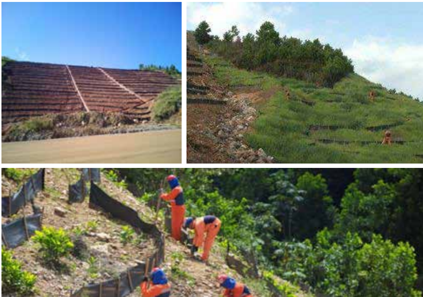
Figura 13. Reforestación con cortinas de sedimentación
