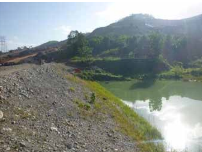
Figura 16. Poza de infiltración de la presa de colas
